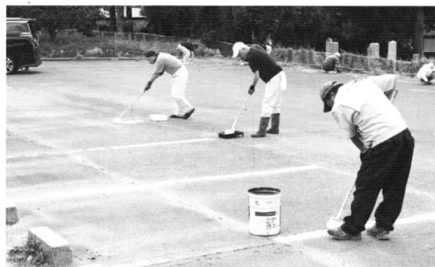
ローラーで塗料を塗り直す
