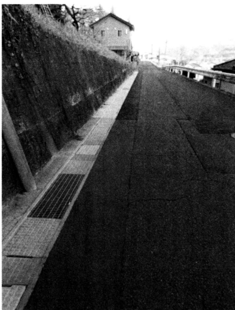
宮田宅～飛沢宅下側溝整備二期工事まで完成の写真
