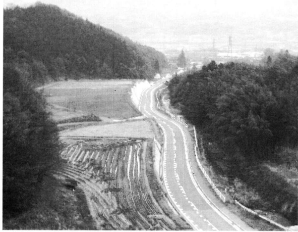
開通した湯ヶ洞街道
