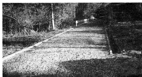
学校平U字溝布設工事
