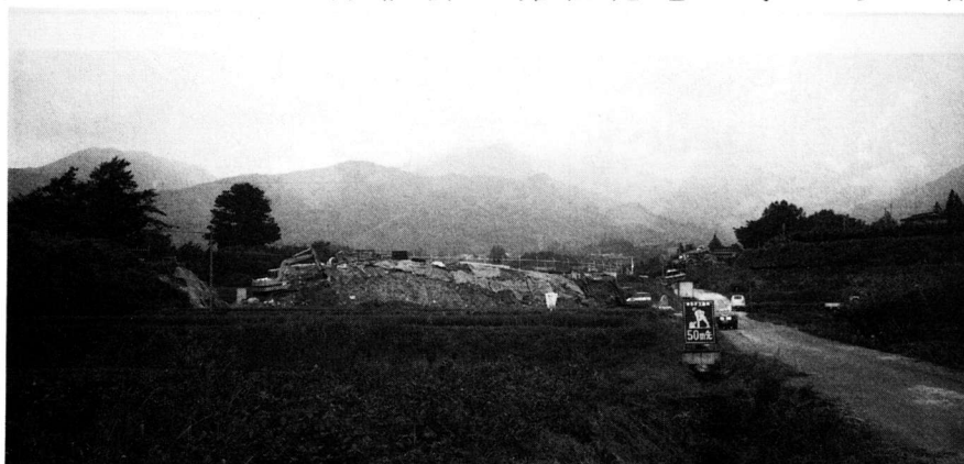
改修工事中の間ヶ沢堤
