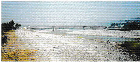
平成8年(1996)、架け替えられた橋
