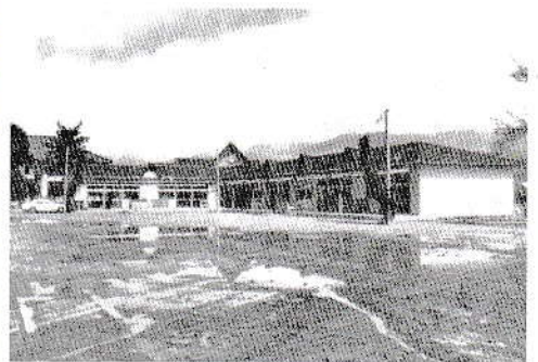
下市田学校の校舎を廃止し保育所となる。 〈昭和56年3月(1981)完成〉
