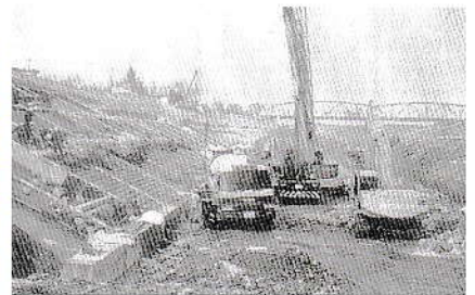
36災害後に補強工事されている出砂原堤防
