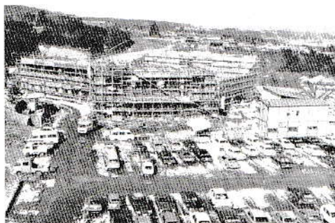
町立体育館建設中
