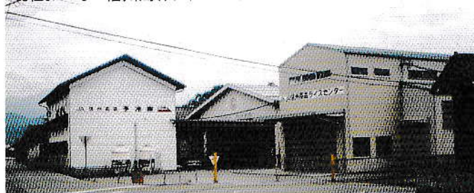
現在JAみなみ信州高森ライスセンター
