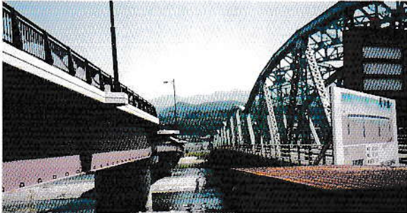
完成した明神橋と間もなく取り壊されようとしている。 旧明神橋(右側の橋)
