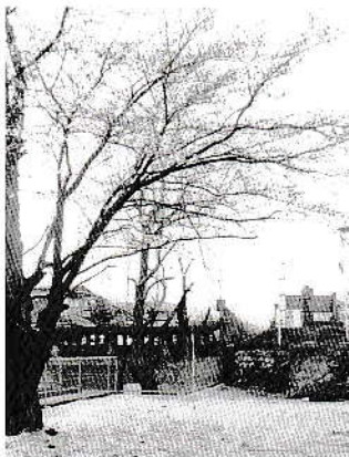
橋の工事前の南の麓
