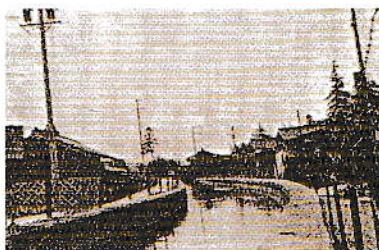
竜西一貫水路市田開渠（第三隧道前）
