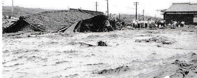
天竜社屋根まで土石流で埋まる。（三六災害）（昭和36年（1961））
