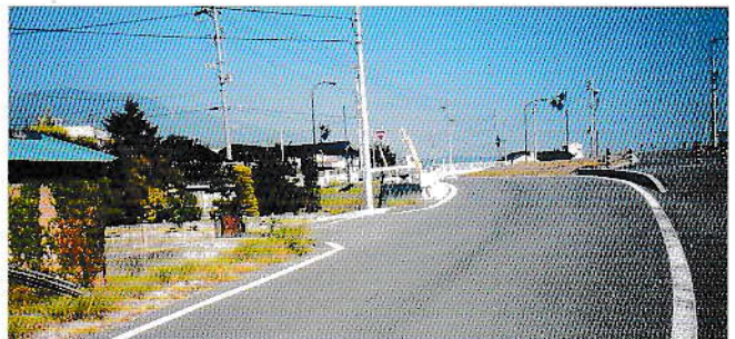
橋の架け替え後の麓の変容
