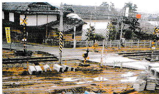
完成間近い踏切辺りの工事
