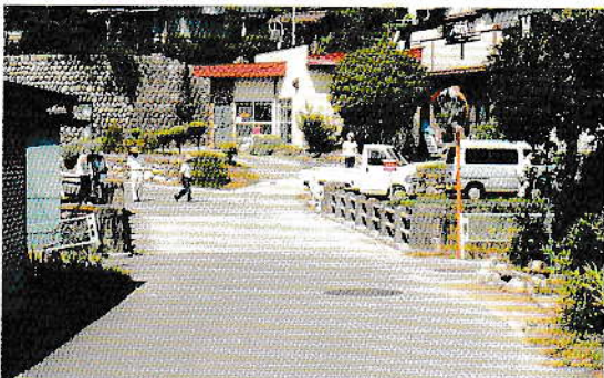
雲井橋の遠景
