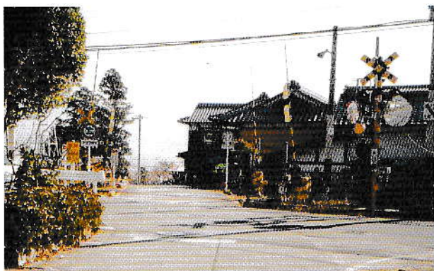
改善された現在の踏切
