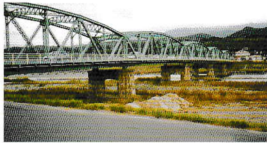
昭和7年(1932)、交通の急増により、ワーレン式曲弦鋼式による橋に架け替えられた。
