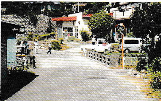
雲井橋の遠景
